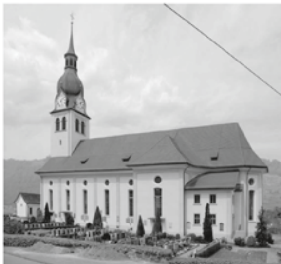
Bild oben: Ansicht von Südosten
