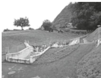
Fertig erstelltes Einlaufbauwerk
