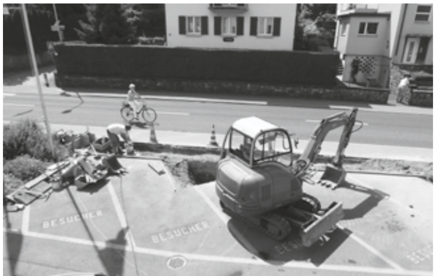
Die Baumgruben werden ausgehoben. Alle Parkplätze bleiben erhalten.
