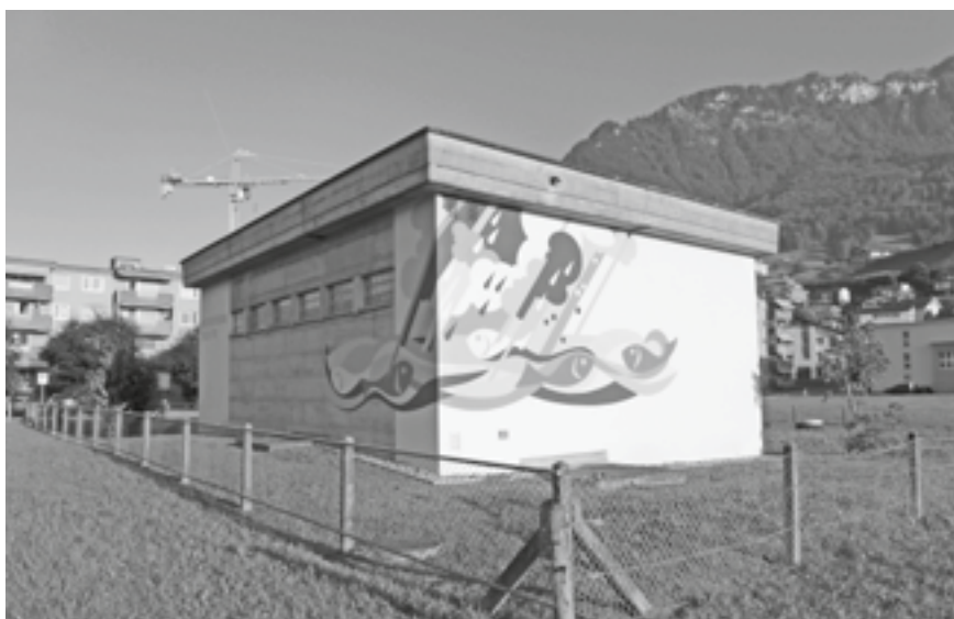
GWPW Schürmatt: Sanierte Wandmalerei aus dem Jahr 1978
