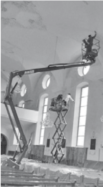
Innenreinigung der Pfarrkirche
