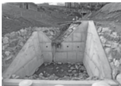
Einleitung Ribibach in Bauwerk
