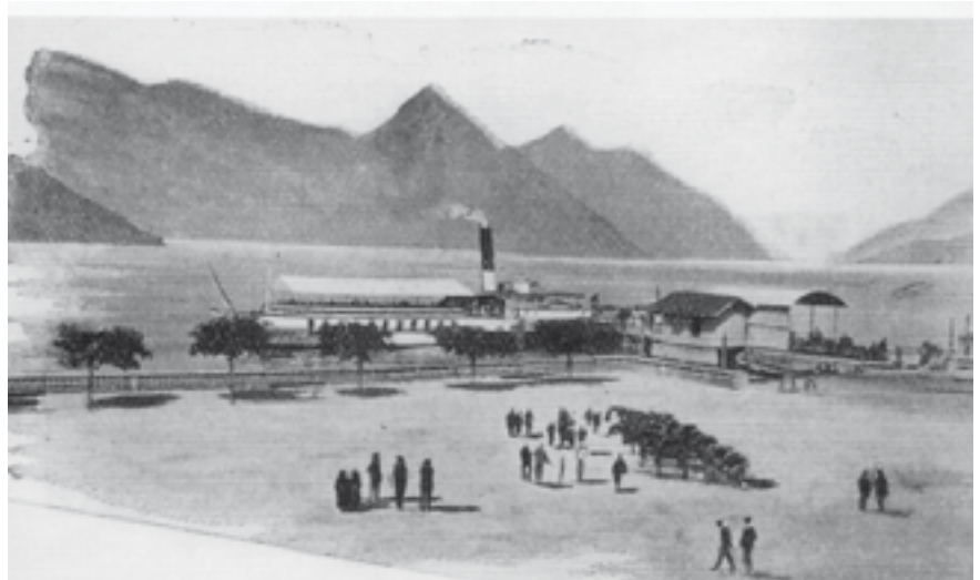
Nach der Aufschüttung, das gewonnene Terrain bei der Schiffstation
