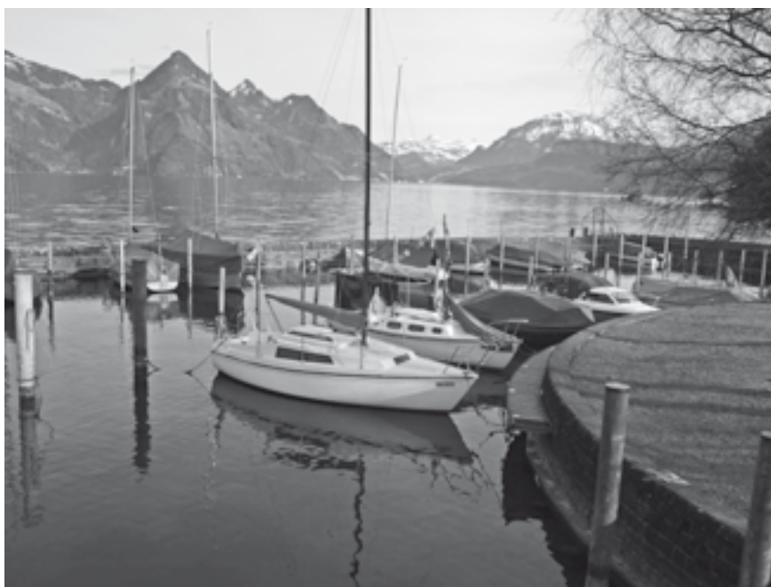
Bestehende Hafenmole wird im Winter abgebrochen.
