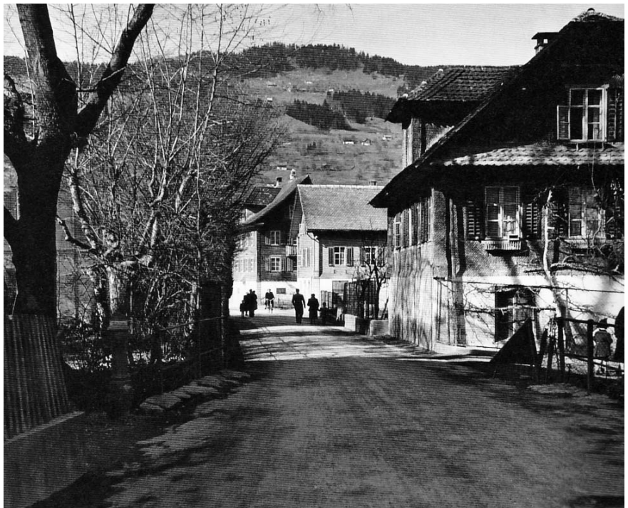
Foto von 1959, die alte Ennetbürgerstrasse vor dem Ausbau. Blick von der Aabrücke gegen Ennetbürgen, rechts vorn Haus von Martin Ettlin
