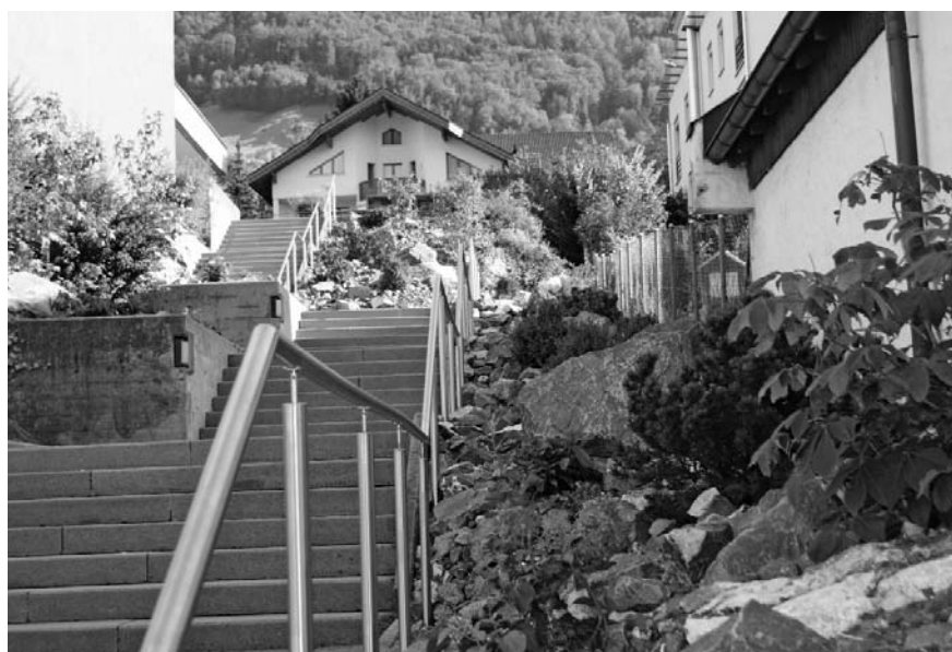
Das neue Treppengeländer beim Aufgang zur Breitlihalle
