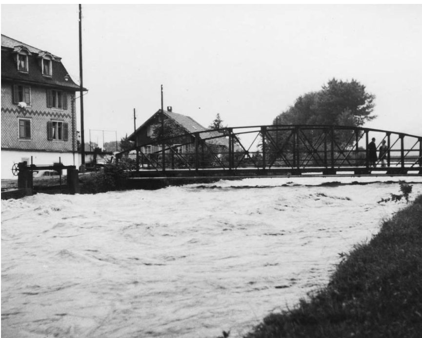
Eisenbrücke über die Engelbergeraawasser vor 1954
