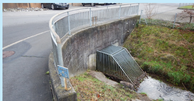
Durchlass Pilatusstrasse im IST-Zustand
