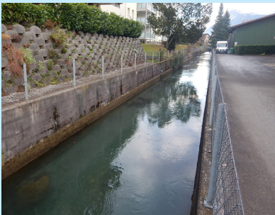
Giessenkanal im IST-Zustand mit Betonwänden
