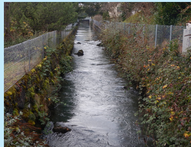
Giessenkanal im IST-Zustand mit Natursteinmauern
