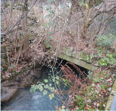
Durchlass Schützenmatte im IST-Zustand
