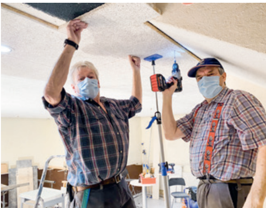
Manfred Spielmann und Fredy Bernasconi bei der Montage der Schallschutzdecken
