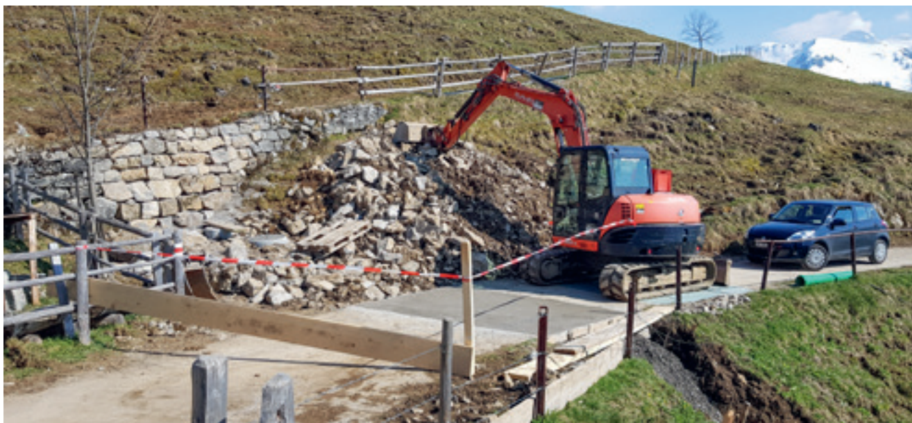
Strassenquerung bei der Alp Arhölzli
