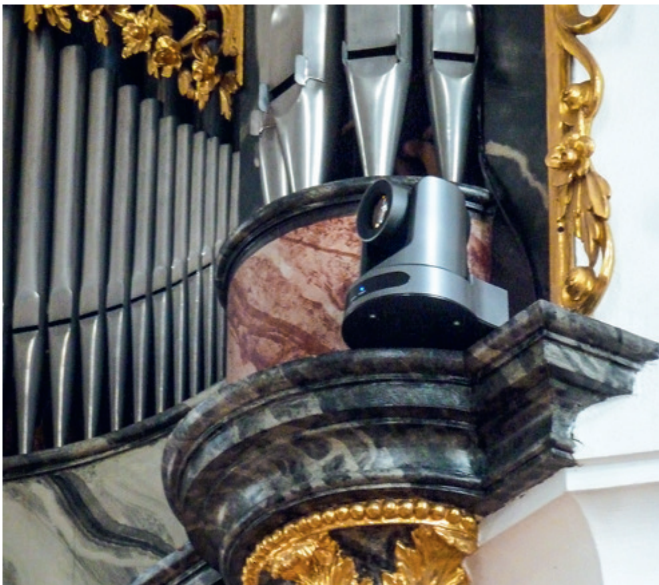
Die unterhalb der Orgel installierte Kamera
