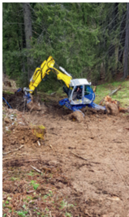
Verlegen der Leitung in steilem Gelände
