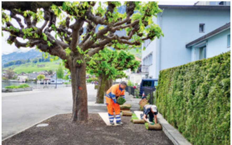
Verlegen des Rollrasens
