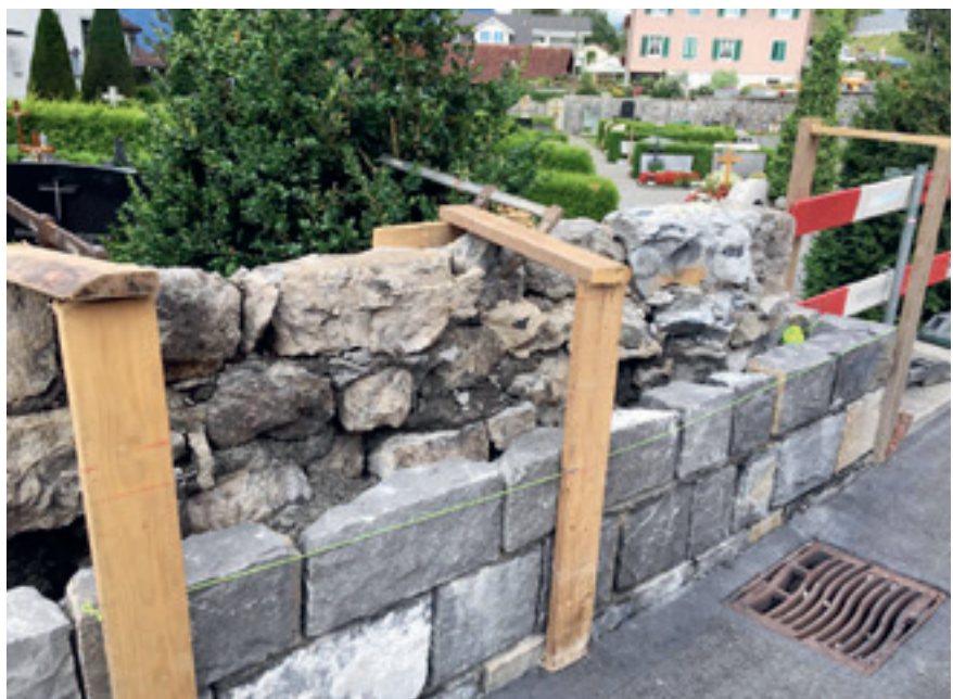
Auf der Friedhof Innenseite Sanierung der bestehenden Mauer – Aussenseite Aufbau mit neuen Bruchsteinen
