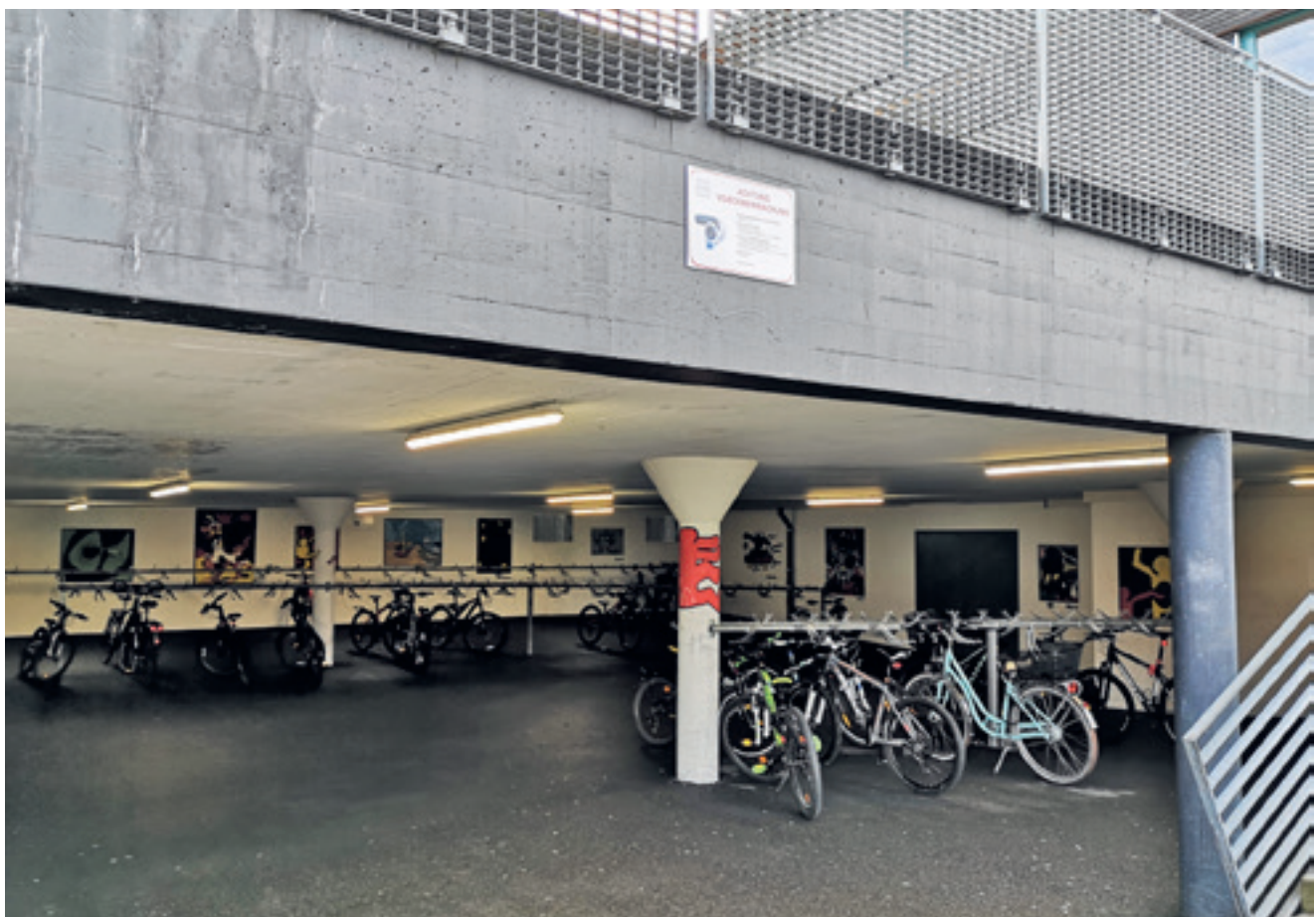
Velokeller Schulhaus Lück II mit Hinweistafel «Videoüberwachung»
