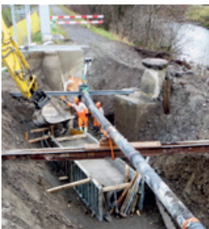
Verlegen Werkleitungen in nördlichen Aawasserdamm
