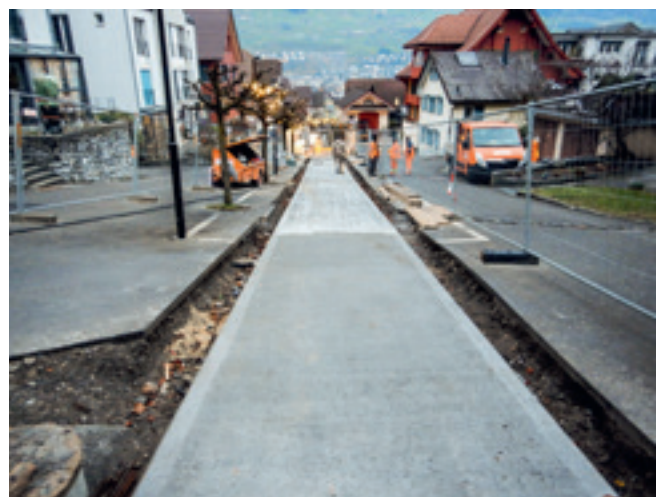
Neu betonierter Betondeckel Durchlass Dorfbach
