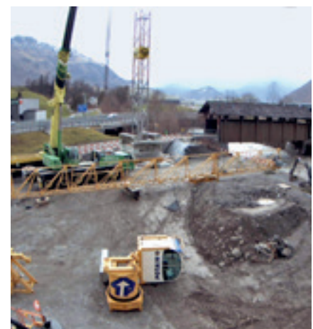
Stellen Kran auf Südseite Aawasser
