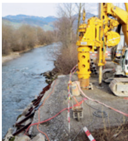
Erstellung Bohrpfähle für Brückenwiderlager
