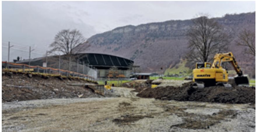
Erdarbeiten für Strasse auf Nordseite Aawasser
