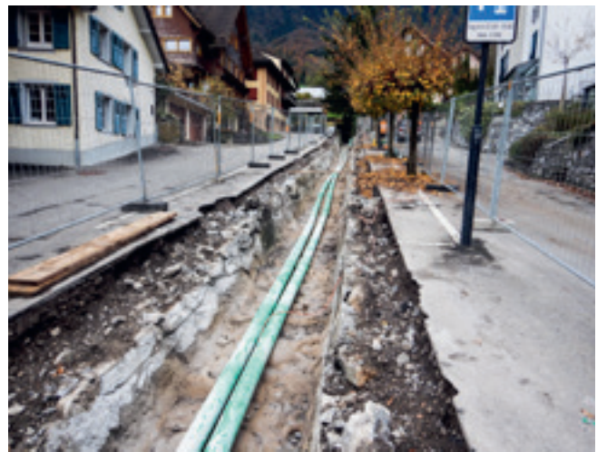
Abgebrochener Betondeckel mit Wasserhaltung
