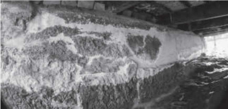
Neu verfugte Natursteinmauer und Betonmauer
