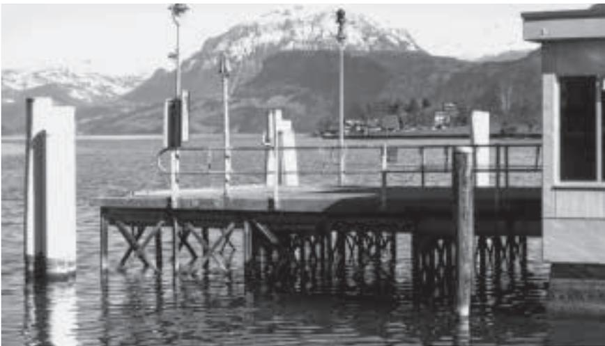
Schadhafter, vorgelagerter Steg / Stahlfachwerk
