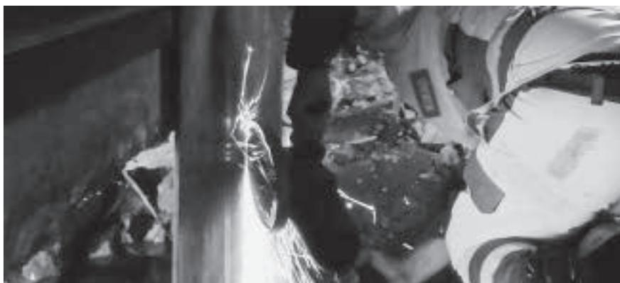
**Erstellung verlorene Schalung (Stahlplatten) für Betonwand**
