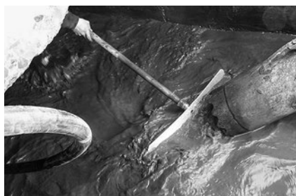
Absaugen von Ablagerungen
