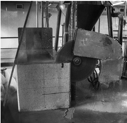
Rückbau Sockel Feinrechen
