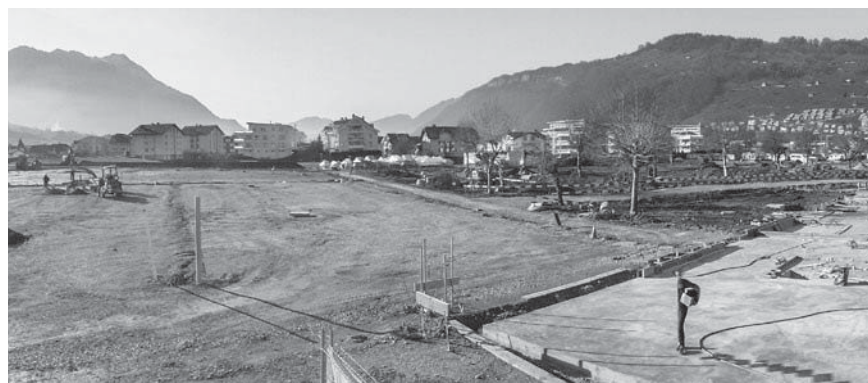
Rohplanie für das Campinggelände mit Fundament für das Sanitärgebäude (rechts)
