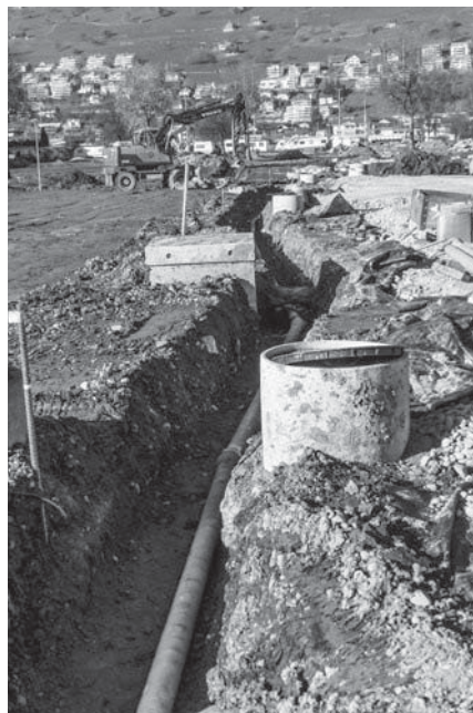
Bau der Infrastrukturleitungen und Schächte
