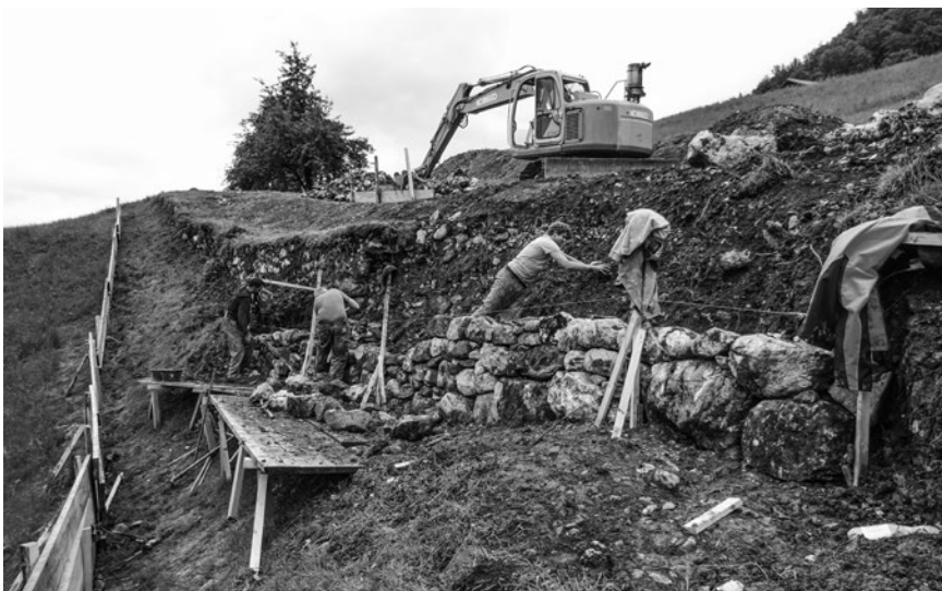
Während der Sanierung
