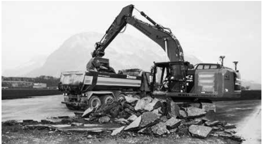
Rückbau Asphaltbeläge
