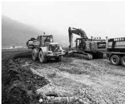
Materialaustausch Unterboden und Einbringen Humus
