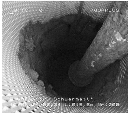
**Foto aus TV-Befahrung Vertikalbrunnen in 15,60 Meter Tiefe**
