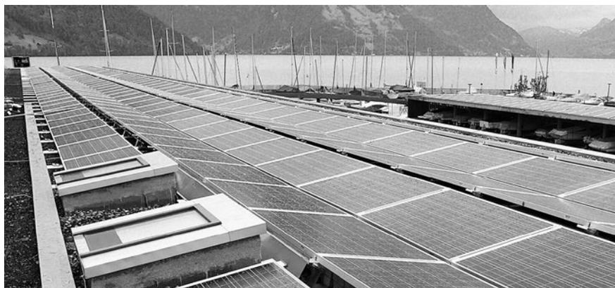
Die Photovoltaikanlage beim Bootshafen hat eine maximale Leistung von 300 kWp und ist mit einer Modulfläche von 1'889 m<sup>2</sup> momentan die grösste Anlage im Gemeindegebiet.
