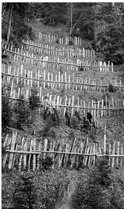
Lawinenverbauung mit Pfahlreihen im Rottimattzug (1915).
